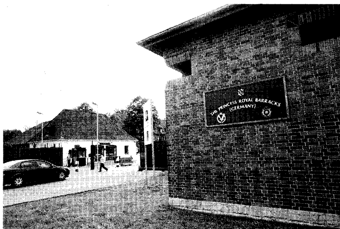
Britischer Standort: Die Princess-Royal-Kaserne in Gütersloh. Die Streitkräfte investieren Millionen in der Region. FOTO: MARTIN SCHLEDE
